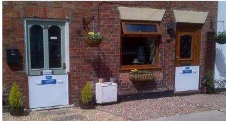
Figura 9.11 – Paratoie manuali a protezione di porte di ingresso
