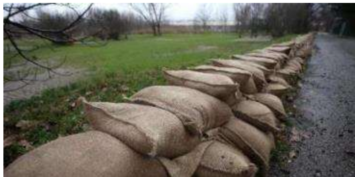
Figura 9.4 – Barriera temporanea antiesondazione in sacchi di sabbia
