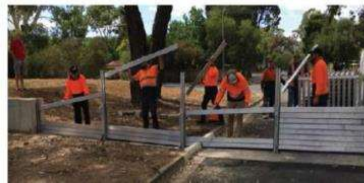
Figura 9.9 – Barriera temporanea modulare con pilastri e panconi manuali in alluminio
